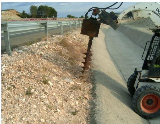
Figura 11. Excavación para cimentación
