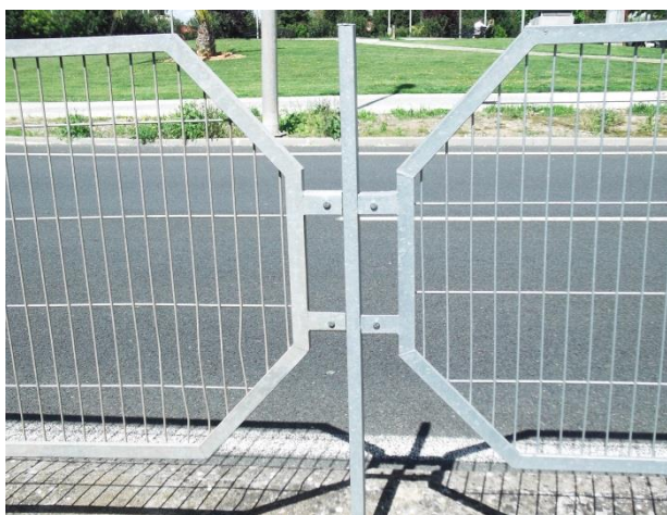
Figura 3. Detalle de unión atornillada y cantos achaflanados
