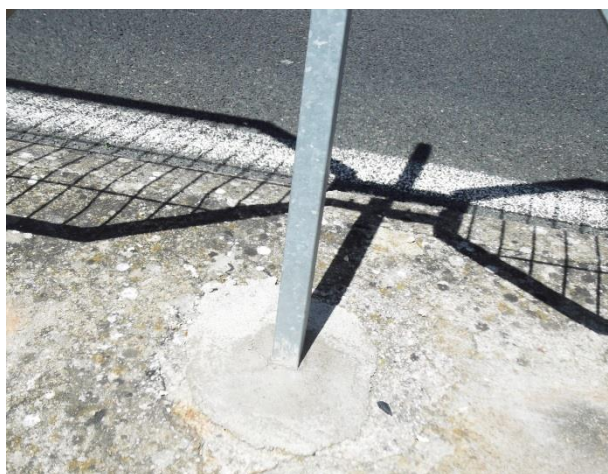
Figura 4. Detalle de poste hormigonado
