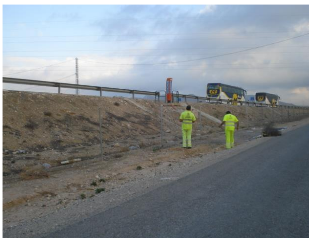
Figura 15. Tensado de alambres de borde y colocación de malla de cerramiento
