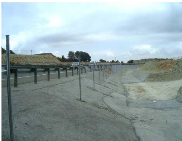
Figura 13. Aplomado, nivelado y hormigonado de postes
